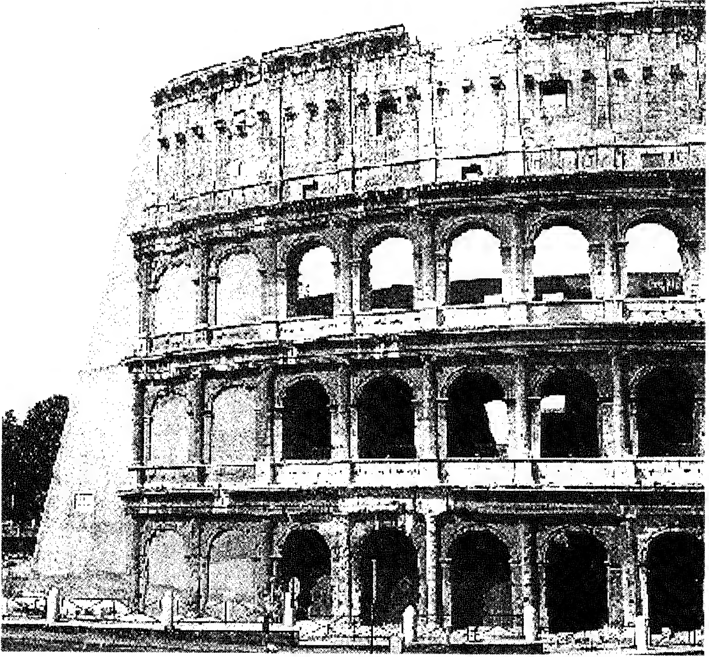
(الشكل ٢ أ): روما، الكلوسيوم، التدخل الحفازي الذي قام به ستيرن العام ١٨٠٦، حيث بنى جدارا داعما في نهاية المعلم بمادة الطوب الأحمر مختلفة عن مادة بناء المعلم الأصلي.
